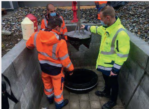
Bild 1: Geöffnete Molchschleuse «Quick-Pig» bei der IBN - sichere und effiziente Bedienung ohne Schachteinstieg
