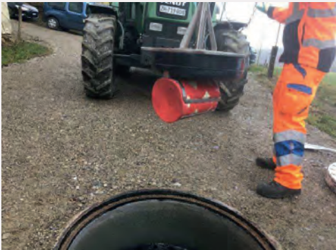
Bild 3: Der Molch hat seinen Zielpunkt erreicht und kann mit dem Fangkorb sauber und sicher aus der Druckleitung entnommen werden.
