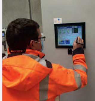
Bild 5: Erfolgskontrolle der Molchung durch Verifizierung des Betriebspunktes der Pumpen im ausgelegten Bereich
