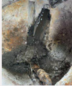
Bild 4: Ausgetragene Schmutzfront im Empfängerschacht, kurz vor dem Eintreffen des Molches
