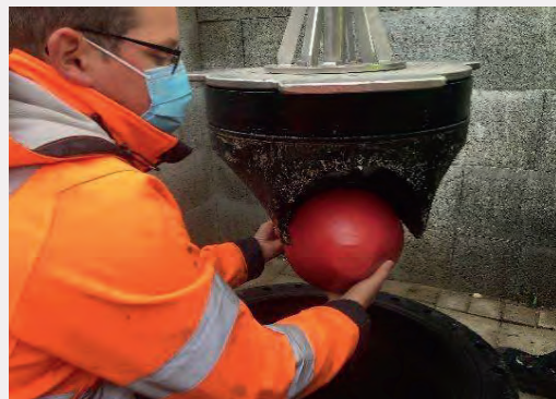
Bild 2: Einfaches und arbeitssicheres Einlegen des Molches in den Sender vor dem Einbringen in die Druckleitung
