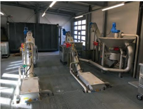
*Blick ins EG der Vorbehandlung mit zwei parallelen Kompaktanlagen, Sandwäscher (rechts) und Abluftfilter im Hintergrund.*
