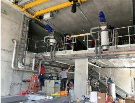
*Blick in die Schlammmentwässerung kurz vor Inbetriebnahme. Im OG die beiden Schneckenpressen, sichtbar sind die beiden Austragsschnecken, im EG die Podeste der Schlammmulden und im Hintergrund die Flockungsmittelinstallationen.*
